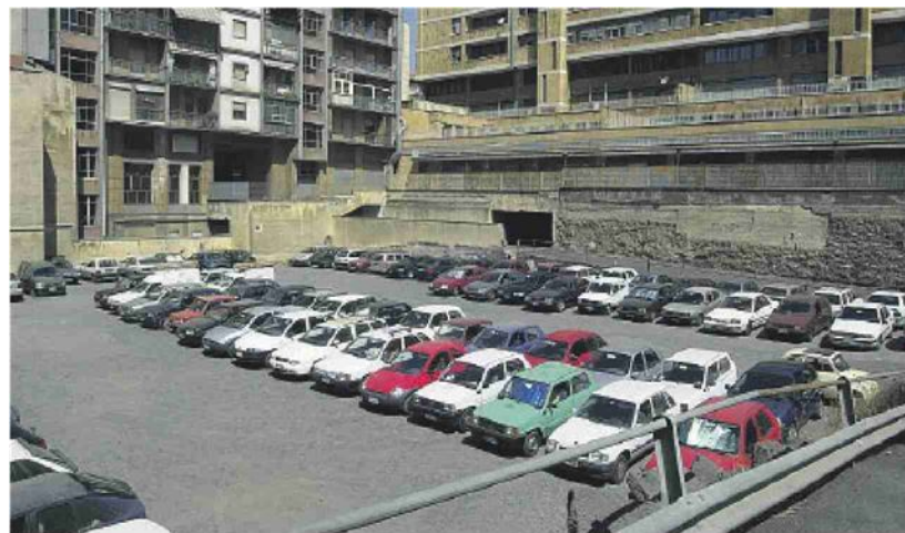
Sopra, il parcheggio "Sturzo". In alto il parcheggio Sanzio quasi ultimato
