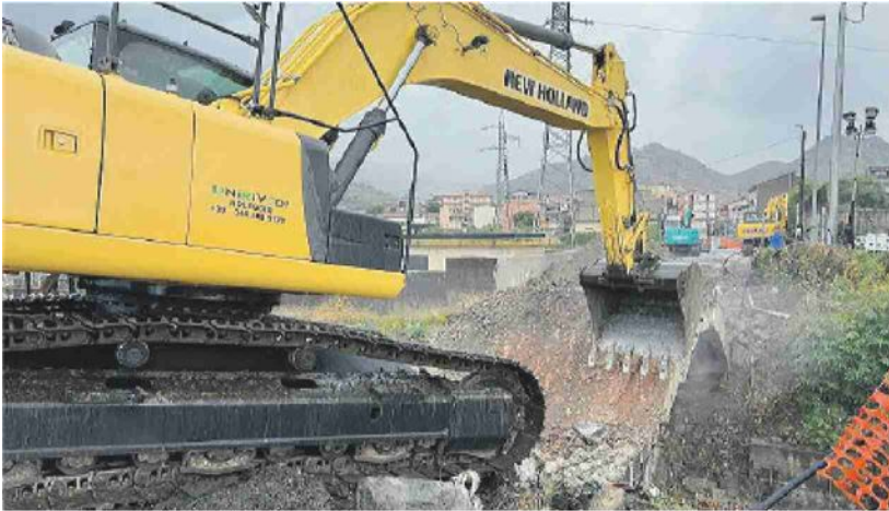
La demolizione del ponte a Calatabiano
