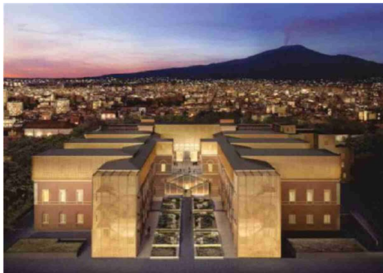
Uno dei render inseriti nel progetto per trasformare l'ex Vittorio Emanuele nel Museo dell'Etna
