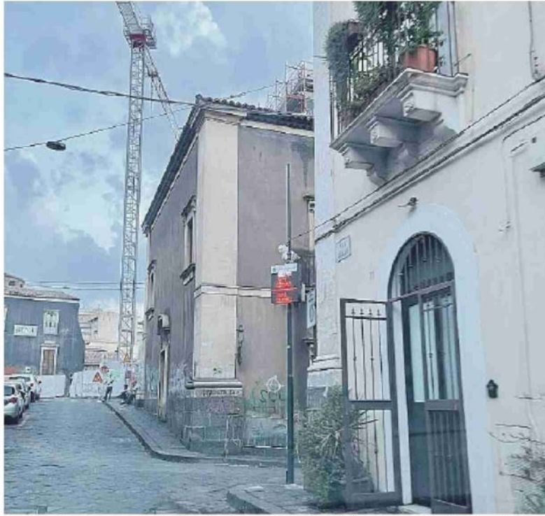
In alto il varco in uscita da via Cerami su via Gallo, sopra via di Sangiuliano
