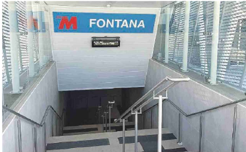
L'INGRESSO DELLA NUOVA STAZIONE METROPOLITANA DI VIALE FELICE FONTANA
