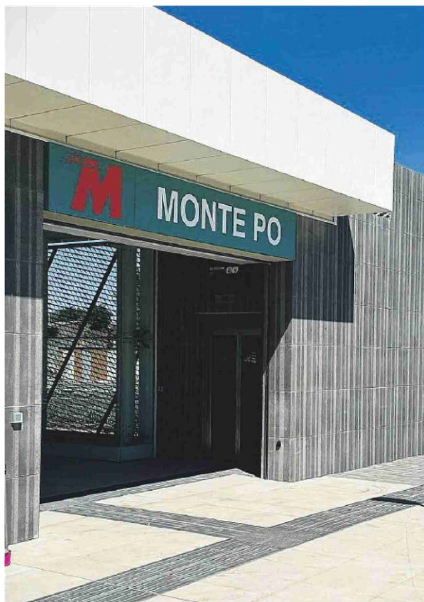
L'ingresso della nuova stazione metropolitana di Monte Po
