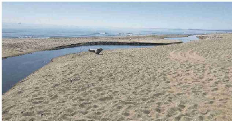
Il danno provocato dalle correnti che hanno "spostato" il letto dell'Arci
