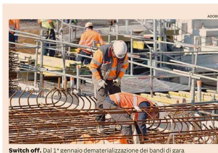
Switch off. Dal 1° gennaio dematerializzazione dei bandi di gara
