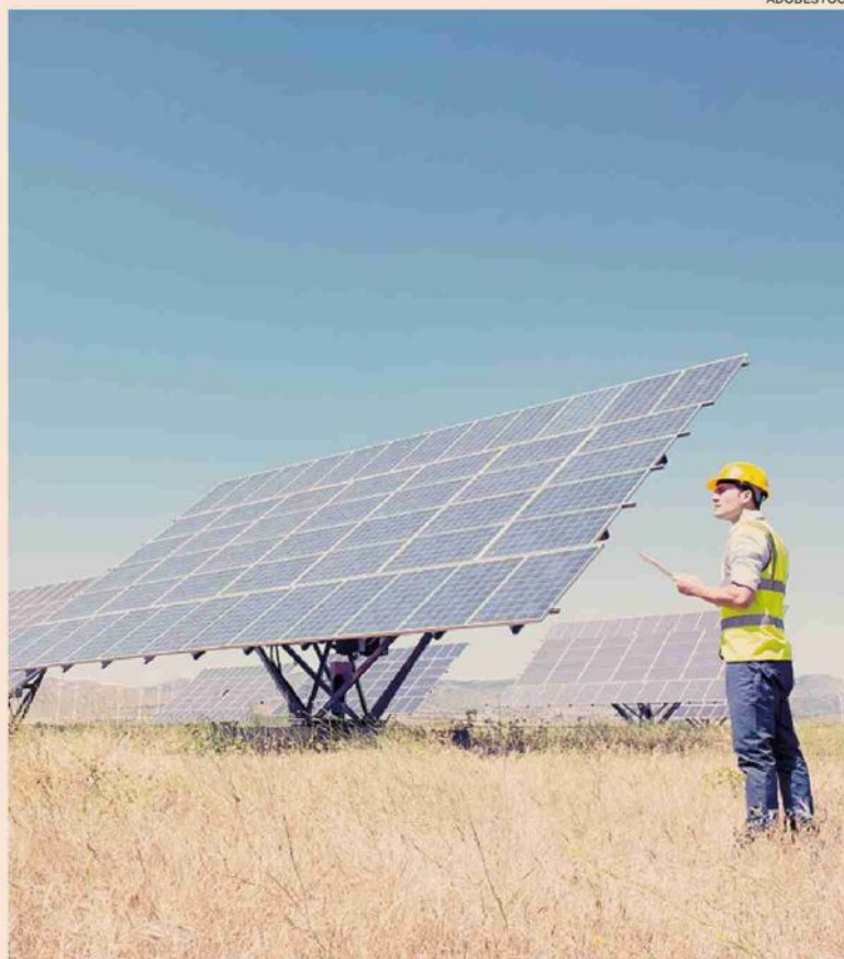
Il fotovoltaico e la sua filiera. Sono 25mila gli impiegati nel settore in Italia
