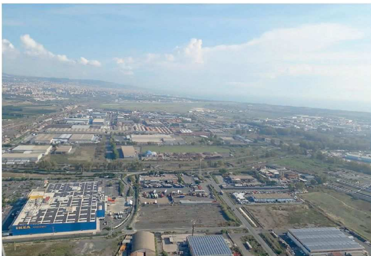
Una veduta aerea della zona industriale
