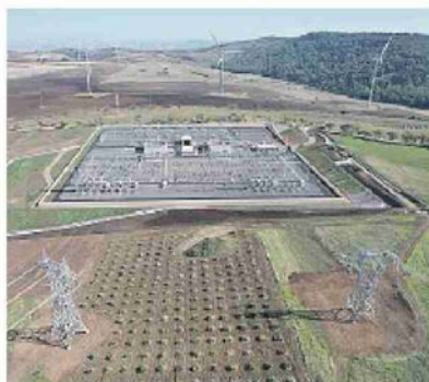
La stazione elettrica di Vizzini
