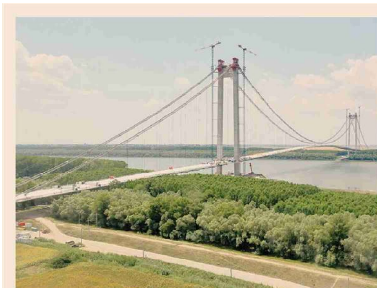
Romania. Sarà pronto entro l'anno il ponte di Braila in Romania. Realizzato da Webuild, il ponte collegherà le due sponde del Danubio nell'area di Galati-Braila
